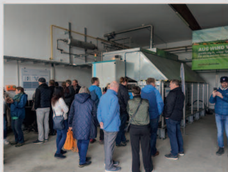
Power2Gas- Anlage bei den Stadtwerken Haßfurt
